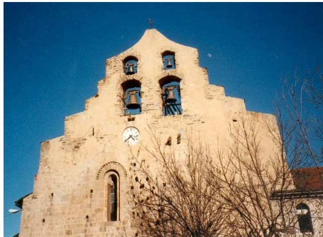
Façana de l'església de Formiguères
